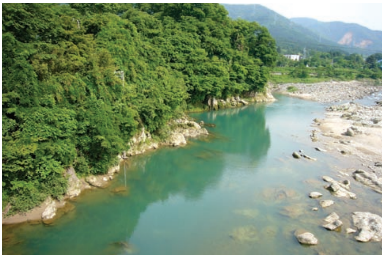
枝権兵衛が穴繰り工事をした手取川「安久湊ヶ淵」(白山市白山町)
