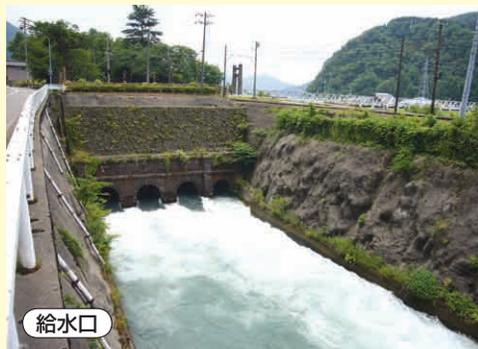
な七ヶ用水の取水口となる大水門を安久湊ヶ淵の岩山に構え、3条の隧道を掘鑿(250m×3)、給水口から約8kmの幹線水路を掘割し各用水への堰、水門等を設置しました。明治36(1903)年に完成した大事業は、工事費約20万円(現在の100～200億円位?)、延べ約10万人が投入されました。この竣工と併せ同年に「手取川七ヶ用水普通水利組合」が創立されました。
