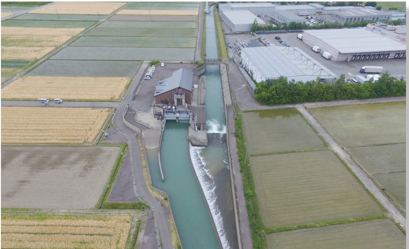
運転開始より20年が経過した「七ヶ用水発電所」(川北町中島地内)
